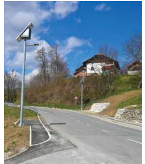
Avtobusno postajališče Prevorska vas v gradnji.
